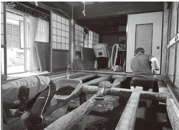
床下の泥出し
