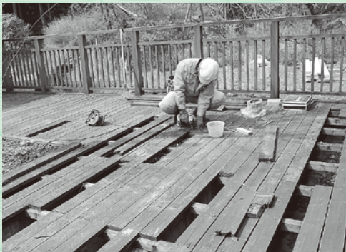
▲ 腐った板を切り取り、新しい板をいれて防腐剤を塗ります。
