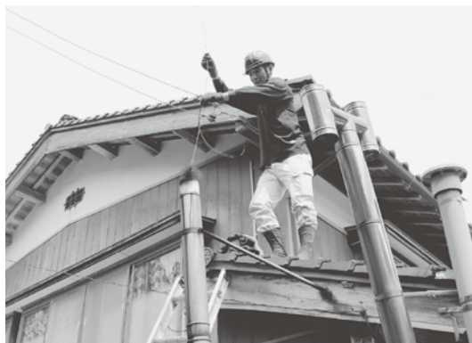
▲ この日のために作成した道具を使って煙突掃除
