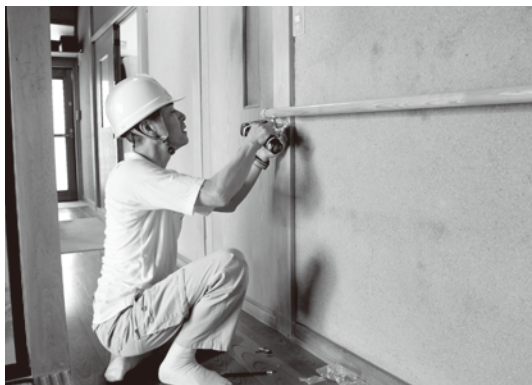
▲ 外れた手すりを再度取り付け。利用者の要望を聞いて高さを調整します。
