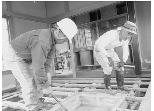
▲床下の泥だし作業をする支援ボランティア
